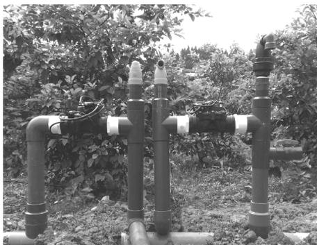
图 16 空气阀装置
